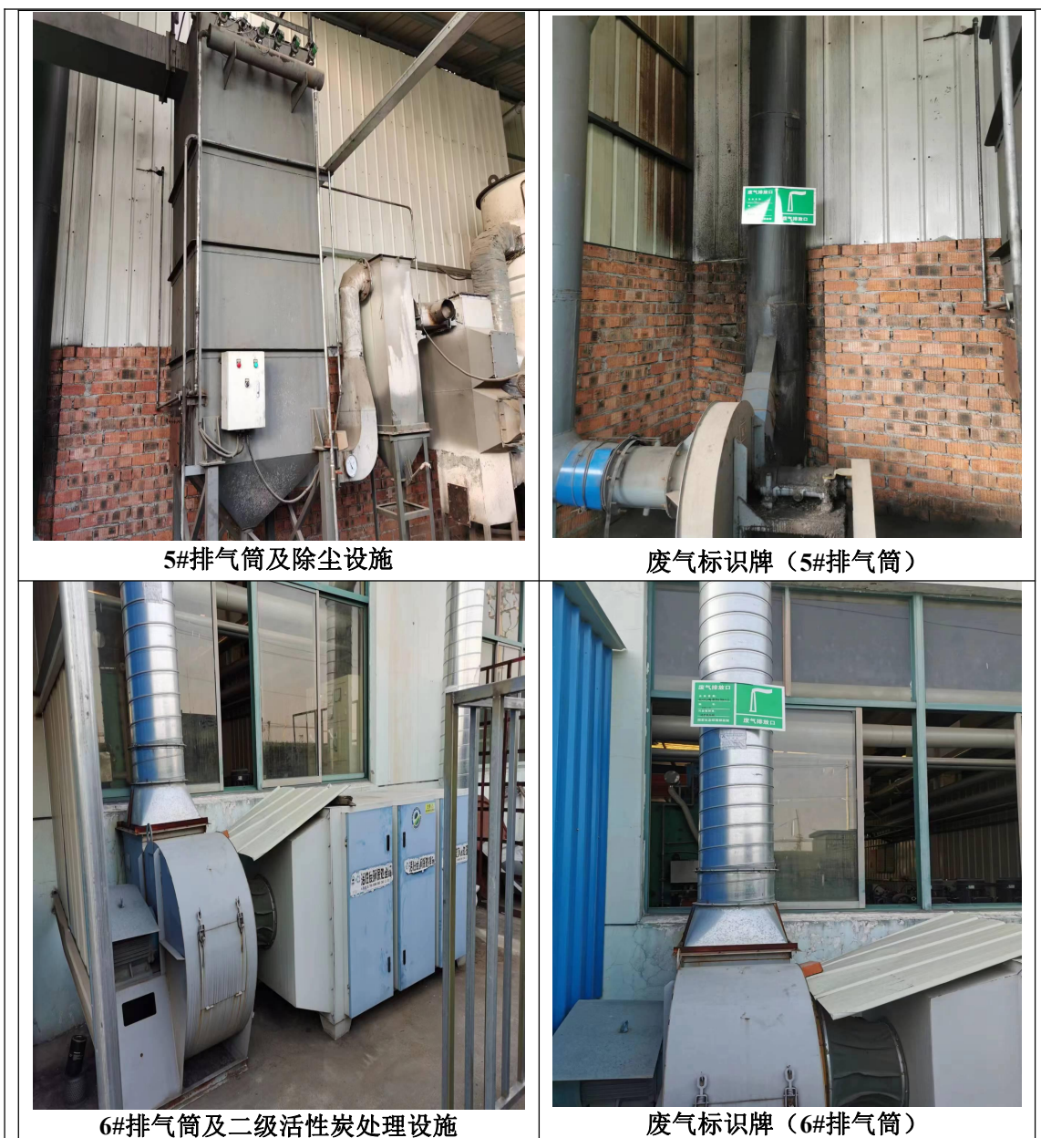
图 3-5 废气处理设施、排气筒及标识牌
